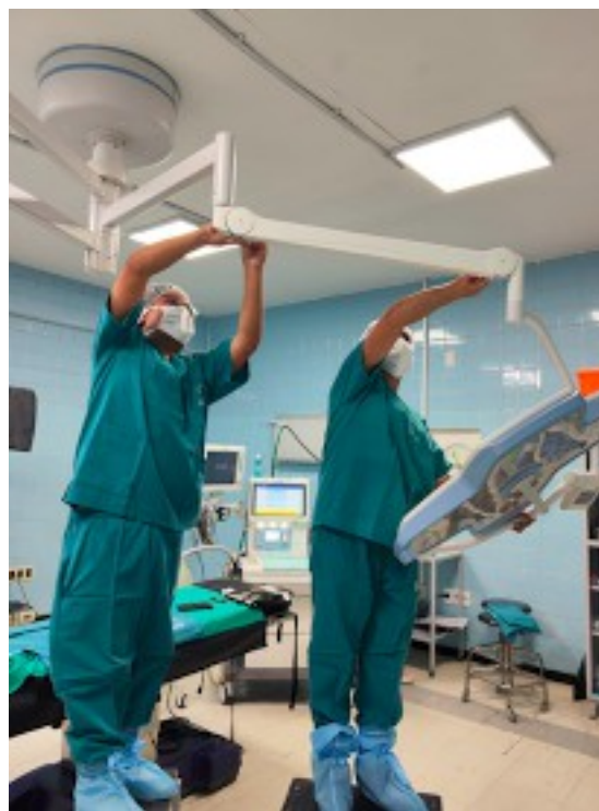
Figura 13: MTP, Lubricación y verificación de partes articulables del sistema del equipo lámpara cialítica.
