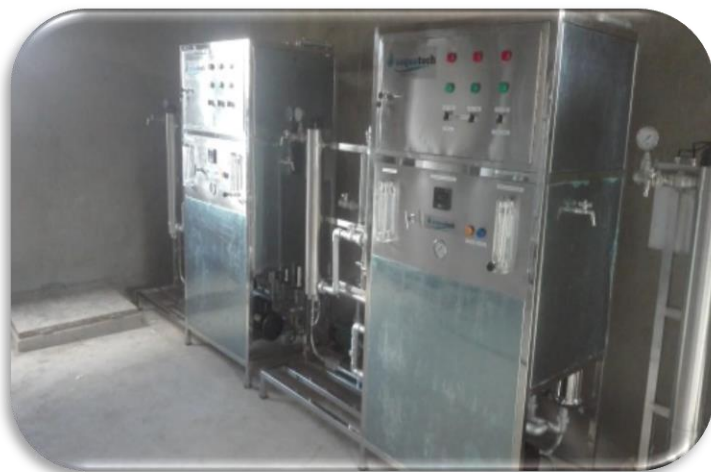
Planta de tratamiento terciario-Servicio de Hemodiálisis
